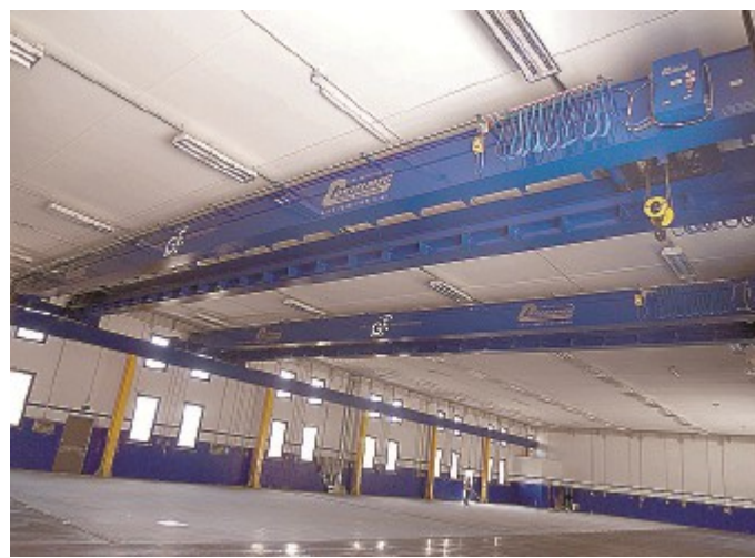
Sollevamento Gli impianti realizzati da Costelmec.
